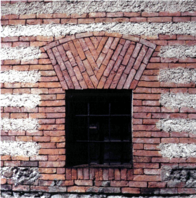
7 Fenster im Schichtenmauerwerk mit scheinrechtem Sturz, voll ausgemauert, aus Hofkirchen bei St. Valentin (NÖ)
