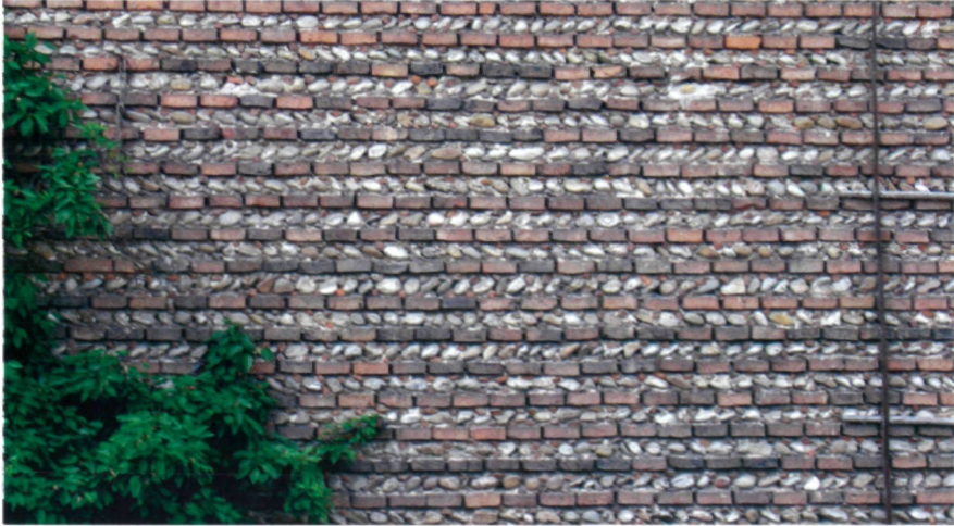
1 Schichtenmauerwerk mit Rollsteinen im Verhältnis von 1:1 verlegt, aus Gunskirchen
