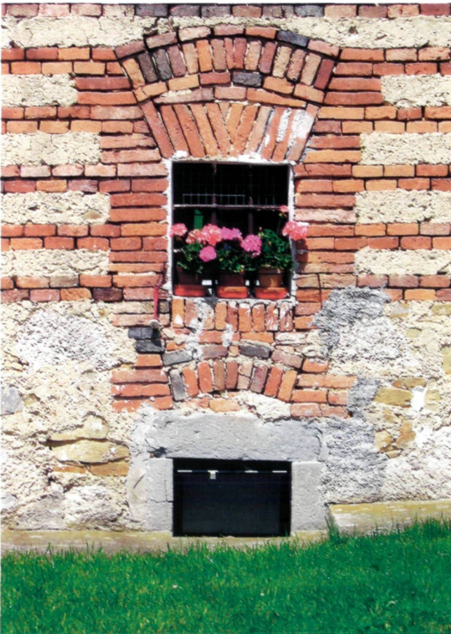
8 Fenster im Schichtenmauerwerk, scheinrechter Sturz, darüber gemauerter Entlastungsbogen, aus Wartberg a. d. Krems
