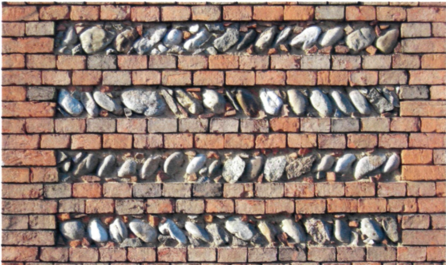
2 Schichtenmauerwerk mit Rollsteinen im Verhältnis von 2:1 verlegt, aus Pyburg (NÖ)
