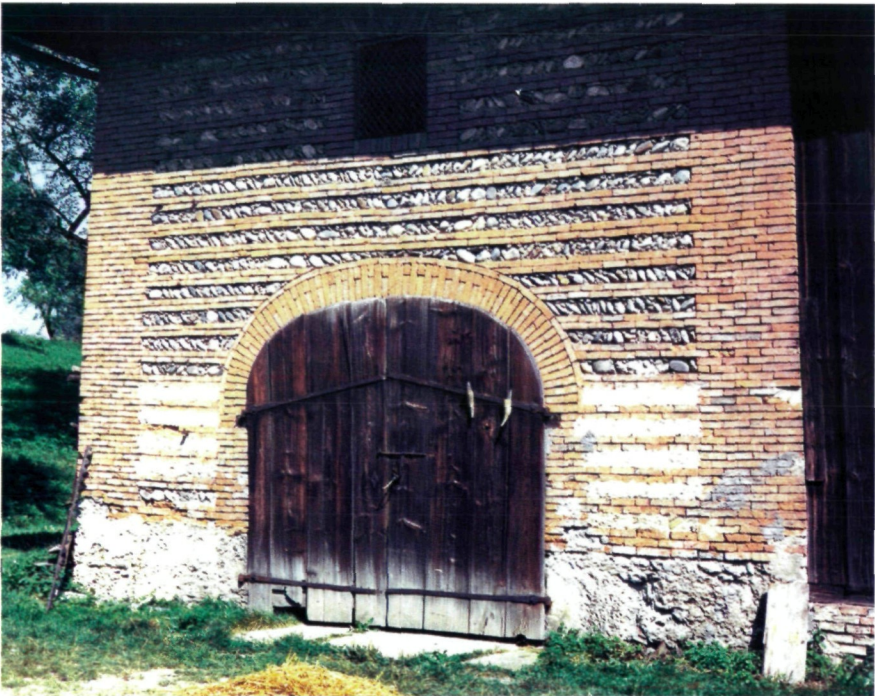
10 Einfahrt im Schichtenmauerwerk mit gemauertem Bogen und gemauertem Gewände, aus Hofkirchen bei St. Valentin (NÖ)
