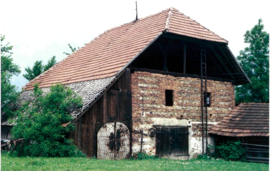
16 Schichtenmauerwerk mit unverputzten Ffysch-Bruchsteinen an einem Nebengebäude in Natzberg, Gemeinde Nußbach
