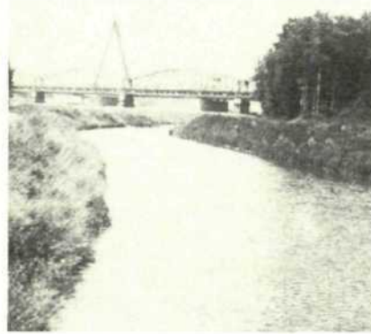
Abb. 7: Umleitungsgraben bei der Steyregger Brücke (Juli 1980)
