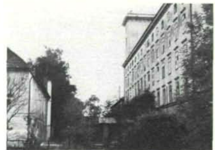
Abb. 12: Der zwischen Industriegebäuden verlaufende Mühlgang ist von einer „Wildnis“ (z. B. Brombeeren) durchsetzt — hier könnten allerdings durch Pflegemaßnahmen reizvolle, ruhige Promenadenwege entwickelt werden.
